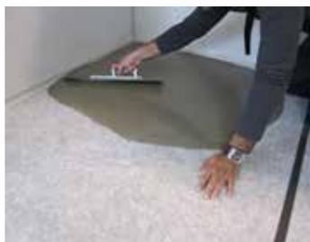
Utiliser les témoins d'épaisseur pour s'assurer d'obtenir au minimum 5 mm de mini chape sur l'ensemble de la surface. Prévoir les dispositifs nécessaires aux arrêts de coulage pour garantir une épaisseur minimale de 5 mm.
