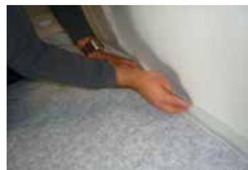
Coller et maroufler la bande de pontage de manière à recouvrir les joints entre les lés.
